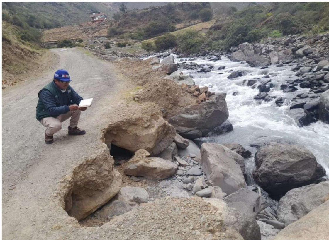
FIGURA N°02: SE APRECIO SOCAVACION EN CAMINO DE ACCESO HACIA EL SECTOR MAYOBAMBA, A LA MARGEN IZQUIERDA DEL RÍO PAROCACHI.
